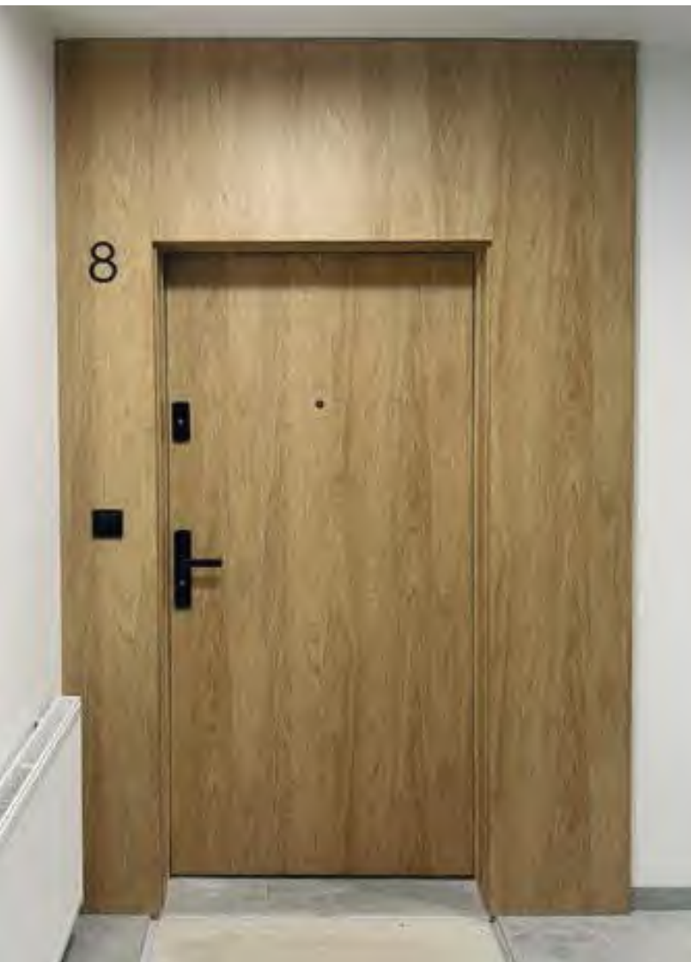
příklad montáže dverí OKTIS RC3
